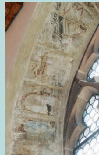
Originale Malerieste in den Fensterlaibungen sollen wieder zum Strahlen gebracht werden.
