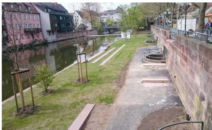
Baustelle auf der Insel Schütt
